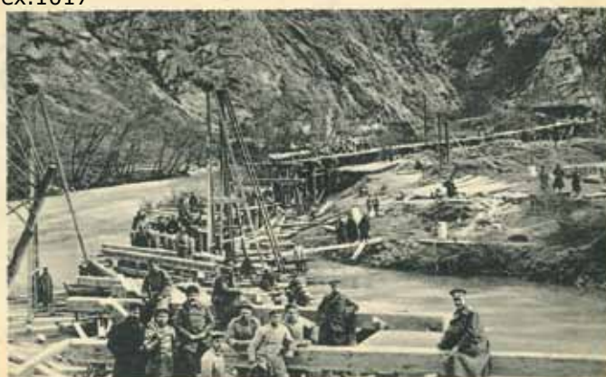
Deutsche und bulgarische Truppen beim Wiederaufbau einer von den Serben gesprengten Eisenbahnbrücke.
